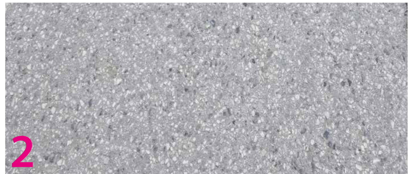
2 Asphaltfläche mit Aufhellungsplitt
